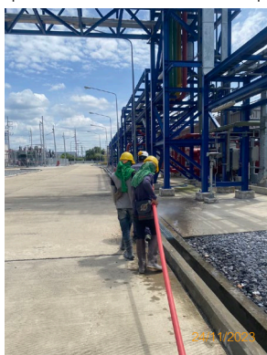
ภาพที่ 2.1-4 ทำความสะอาดรางระบายน้ำ
