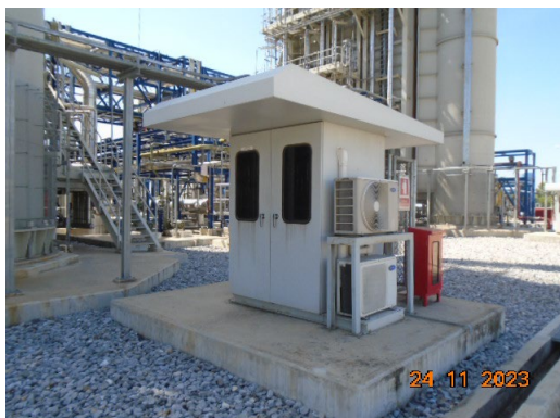
ภาพที่ 2.2-2 ระบบ CEMS ของ ปล่อง HRSG 11 และปล่อง HRSG 12
