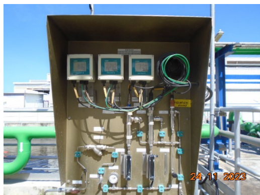
ภาพที่ 2.2-11 ระบบ Online Monitoring บริเวณบ่อพักน้ำหล่อเย็น
