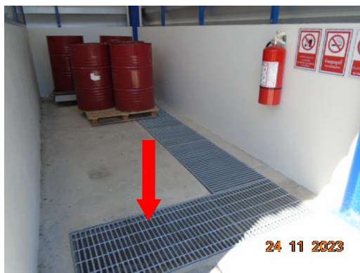
ภาพที่ 2.2-52 รางระบายสารเคมีและน้ำมันที่รั่วไหลออกจากสถานที่จัดเก็บ
