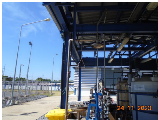
ภาพที่ 2.2-44 ฝักบัวอาบน้ำฉุกเฉินและที่ล้างตาฉุกเฉิน
