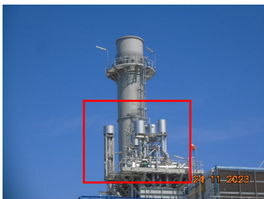
ภาพที่ 2.2-5 Silencer บริเวณปลายท่อที่อาจก่อให้เกิดเสียงดัง
