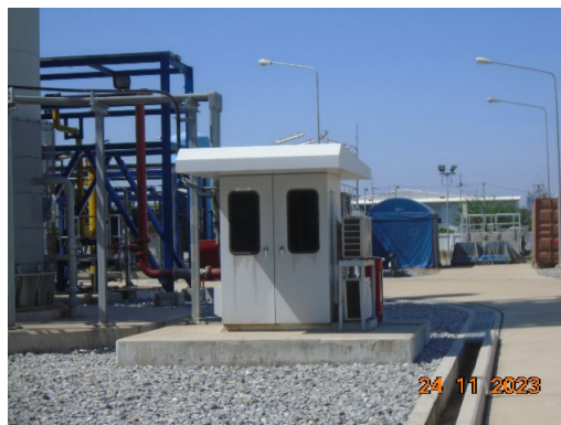
ภาพที่ 2.2-2 ระบบ CEMS ของ ปล่อง HRSG 11 และปล่อง HRSG 12
